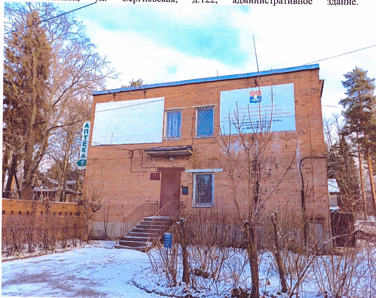
3. г. Всеволожск, ул. Сергиевская, д.122, административное здание.
